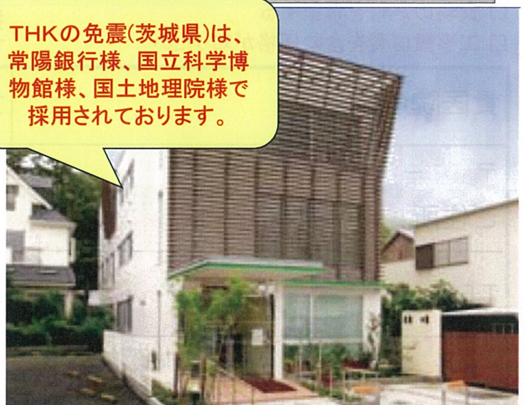
クリニック 兼 住宅 / 神奈川県 (鉄筋コンクリート造3階建 建築面積54.6坪)
